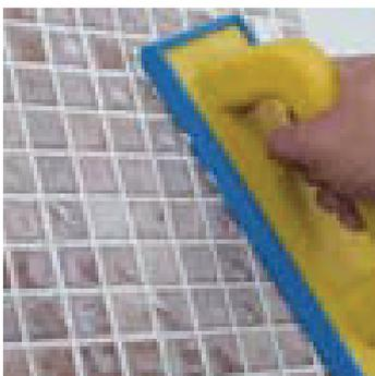
Para efectuar as juntas, aplicar uma camada de produto especial para juntas, com uma espátula de borracha.
