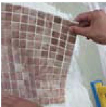
Ajustar e colocar a rede sobre o suporte devidamente untado com cola.
